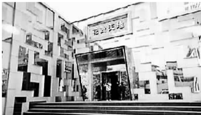
关建军、关建民兄弟大兴土木为自己兴建的豪宅。
