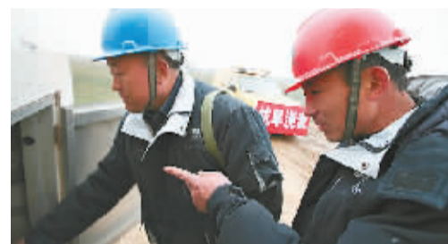
淇县供电公司工作人员在检修浇麦电力设备。左华军 摄
