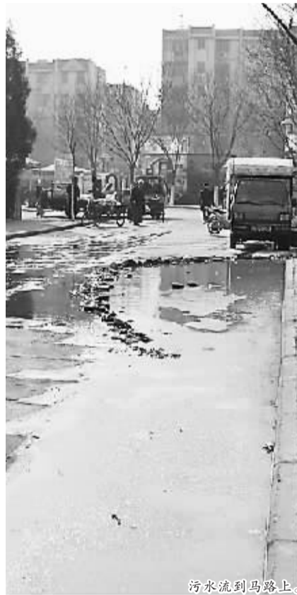
污水流到马路上。
