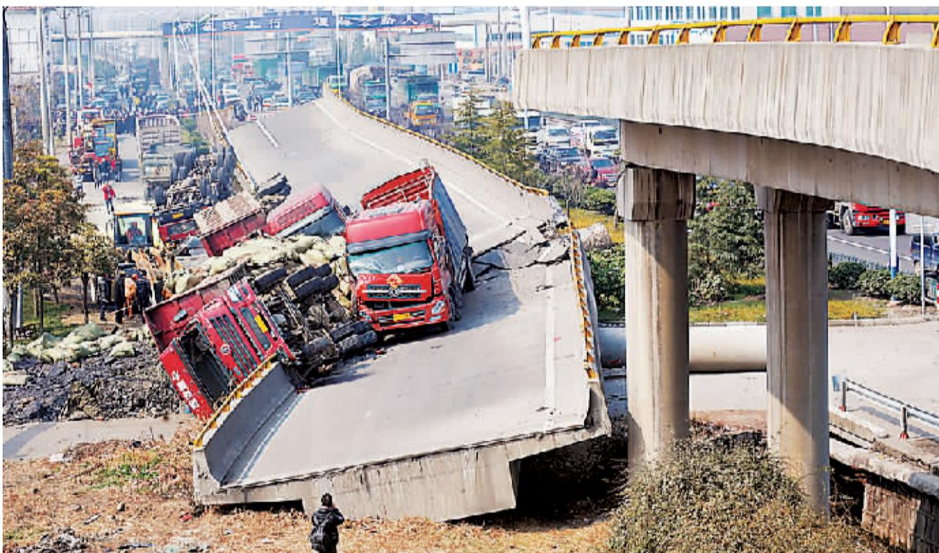
2 月 21 日拍摄的坍塌事故现场。当日凌晨,浙江省上虞市境内的春晖立交桥发生引桥坍塌,坍塌总长度 120 米,最高落差 7 米。事故造成引桥上 4 辆货车侧翻,3 人轻微伤,事故具体原因正在调查之中。
