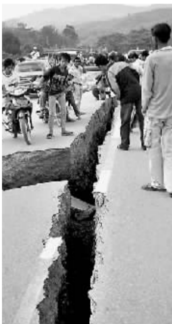
3月26日,缅甸地震灾区居民查看地震后路面上留下的裂缝。 新华社发(吴昂 摄)
