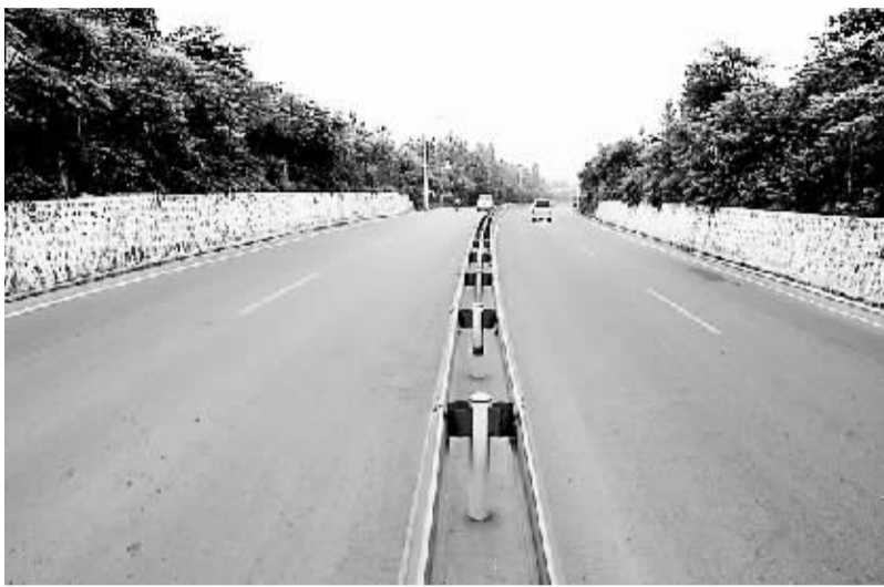
新老区快速通道是我市为协调新老区经济发展,加快城乡一体化进程而专门建设的一条新老区连接线。
