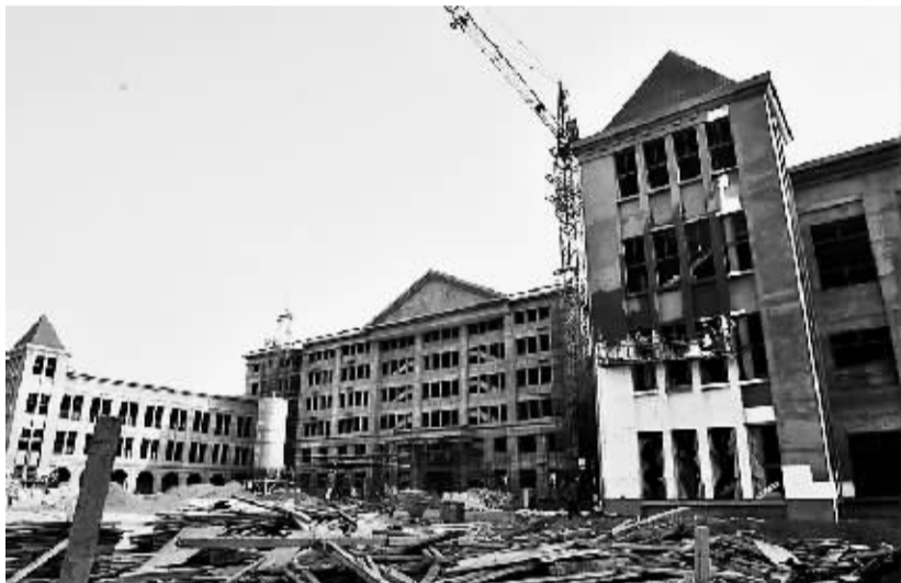
基础教学楼正在进行外墙保温施工。
