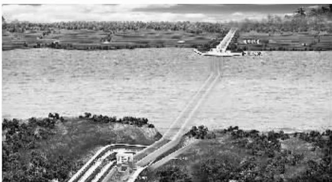
倒虹吸模式示意图。淇河倒虹吸总长506米,设三孔。
