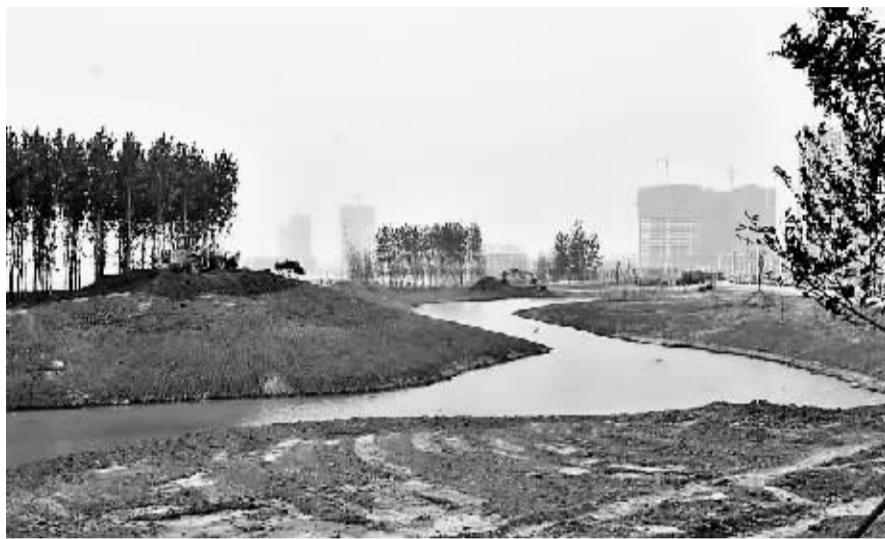
正在建设中的淇水乐园。
