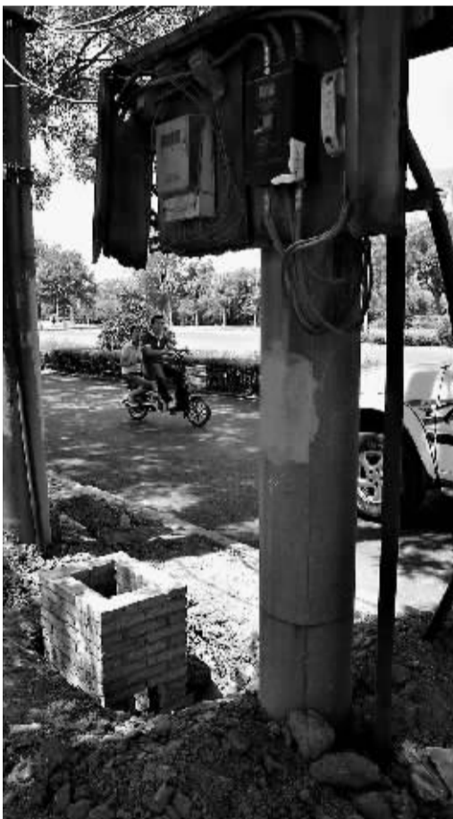
电力部门已开始施工。晨报记者 张志嵩 摄
