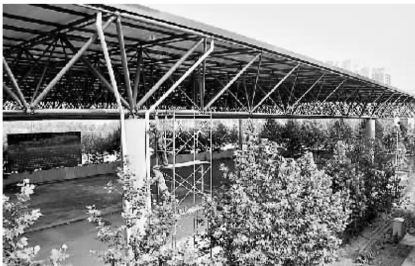
地掷球场馆,工人正在安装排水管道。晨报记者 张志嵩 摄
