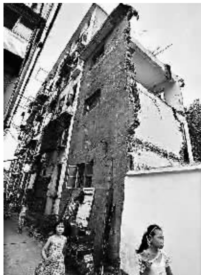
未拆完的墙面像把刀子,竖在居民进出通道旁,一些砖块挂在钢筋上摇摇欲坠。
