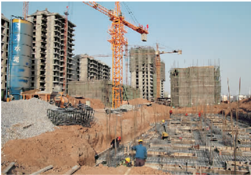
新区一安置小区建设工地,工人们在加紧施工。
