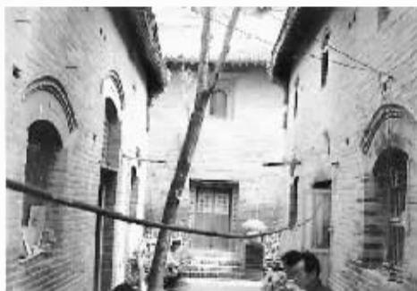
谭贺庭故居北屋正房及东西屋。
