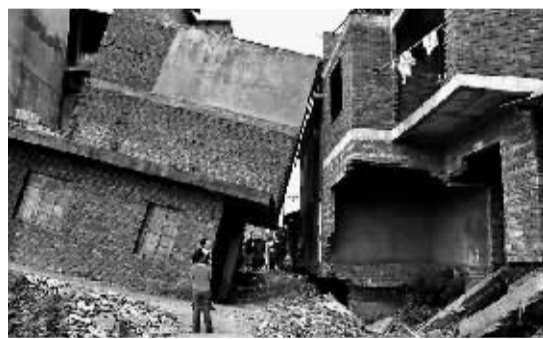
这是未建堤防的另一段——西瓜洲段一座倾斜了近 45 度的居民楼,2010 年 7 月,昌江洪水来时房屋被冲坏(7 月 7 日摄)。
