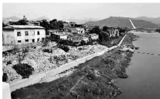
景德镇昌江桥上未完工的城市防洪墙基础线。
