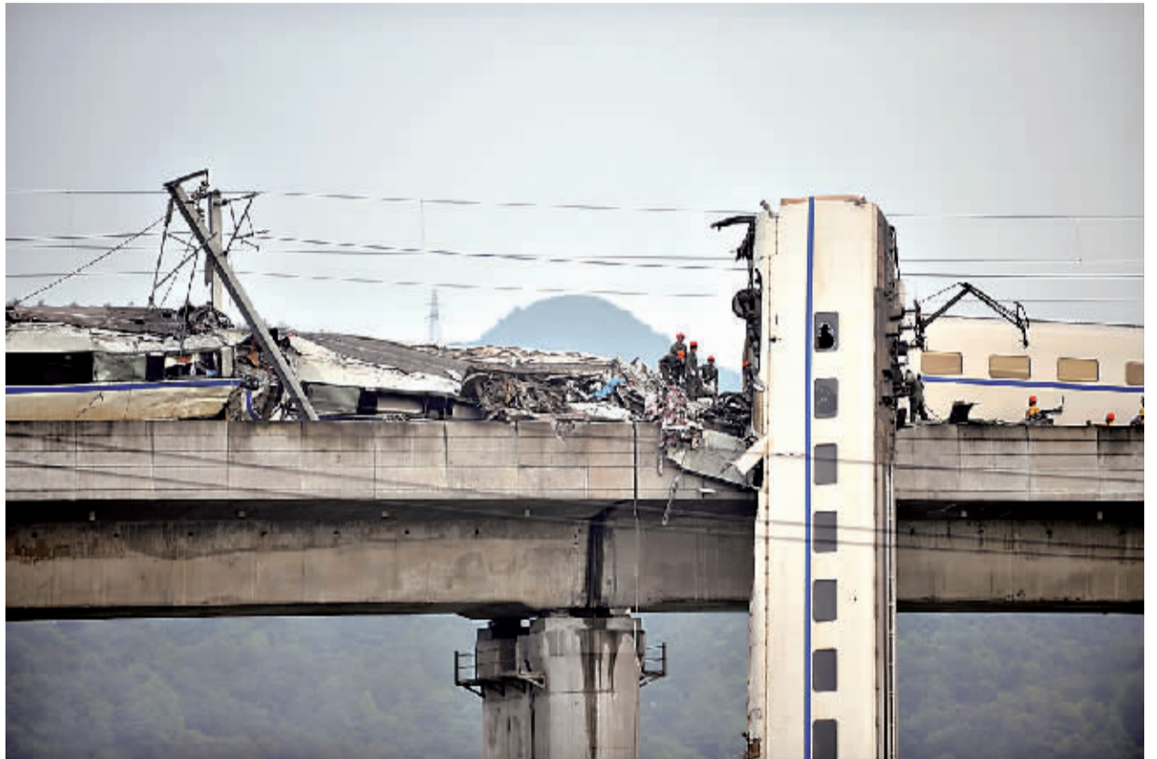
这是 7 月 24 日拍摄的两列动车追尾的事故现场。新华社记者 鞠焕宗 摄
