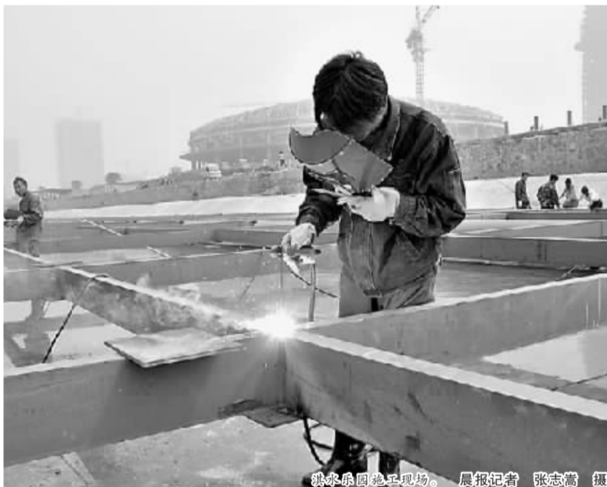
淇水乐园施工现场。晨报记者 张志嵩 摄
