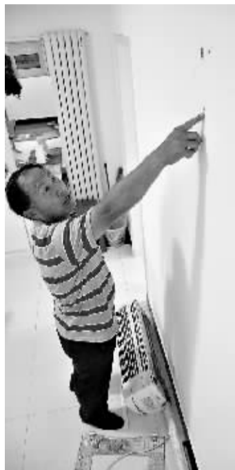
墙上残留着固定空调的钉子。
