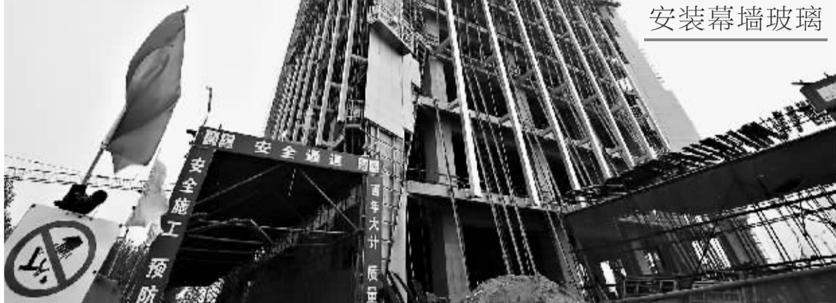
正在建设中的莲鹤大厦。鹤壁日报记者 李国庆 摄
