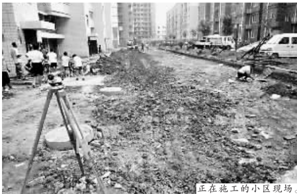
正在施工的小区现场。
