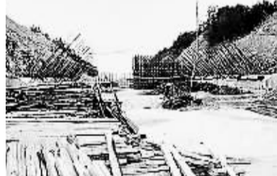
在路面上依山修建一条50米长的隧道。
