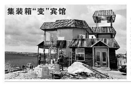
辽宁盘锦鸳鸯沟 旅游度假区内的集装 箱宾馆工程计划将使 用 1500 个废旧集装 箱, 建筑总面积约为 2.5 万平方米。目前已 经完成的 455 个集装 箱、7000多平方米的 模块建筑,包括客房、 餐厅、超市、售票厅 等, 甚至每个房间都 有独立卫生间等功能 区。图为9月14日在 该度假区内拍摄的集 装箱宾馆建筑。
