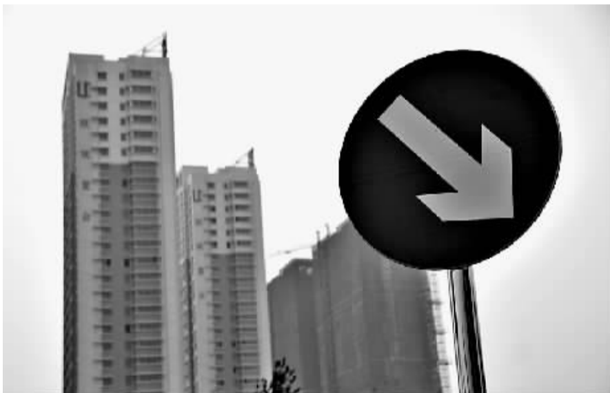
山东青岛市区一处新建楼盘。
