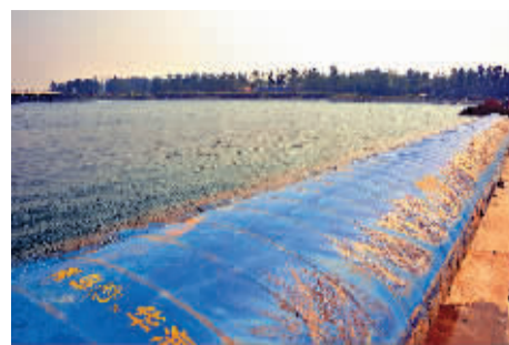
高村橡胶坝满坝。
