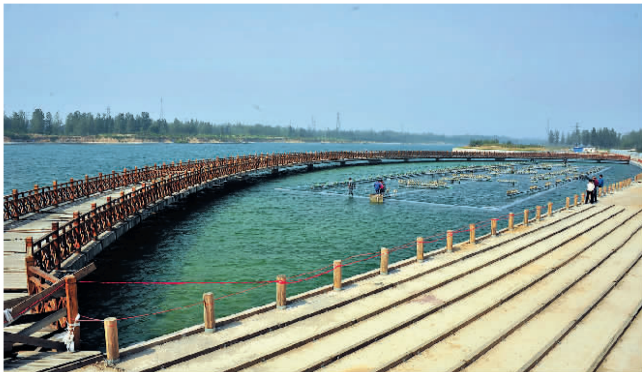
在淇水乐园,工人们正在安装音乐喷泉。
