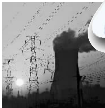
辽宁省阜新市热电厂及附近的输电设施(资料图片,2009年11月21日摄) 新华社发(田卫涛 摄)
