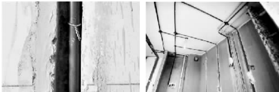
装修时埋藏在墙内的管道一定要固定牢,并且冷热水管分槽固定,而且水管要遵循“走顶不走地”的原则。
