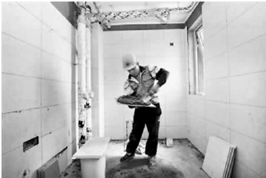
贴瓷砖造成的防水层破损,必须要加上保护层。
