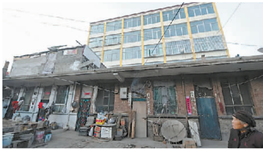
一幢新住宅楼在与上世纪六十年代建造的原兴县化肥厂职工宿舍间距仅1.5米处拔地而起。
