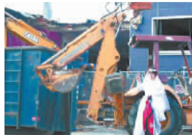
美国女子站在挖掘机前阻止强拆。
