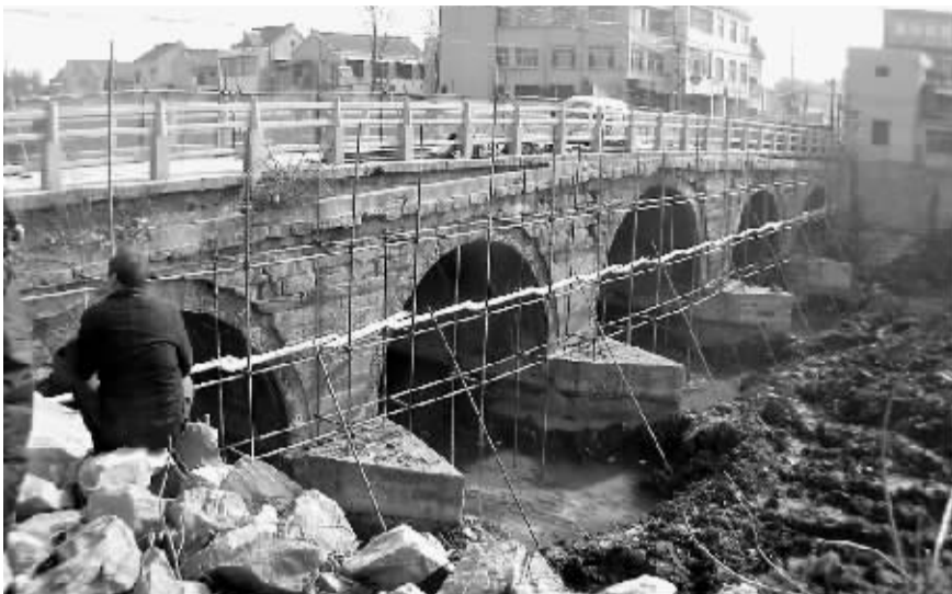
云溪桥修缮现场。
