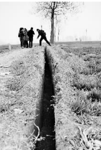
3月21日上午，记者来到浚县王庄镇元过村田间地头，这里刚刚挖好埋管管道灌溉的土沟。王永攀 摄
