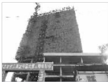
南昌大厦工地。
