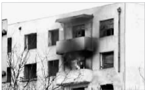
强拆现场，一间房屋起火。
