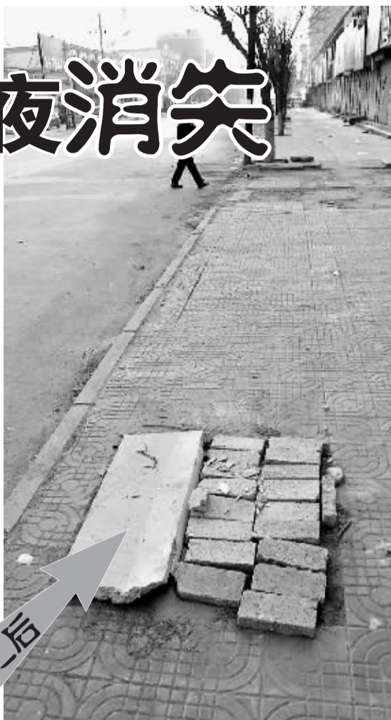
砍伐后残留的树根已经被砖块水泥板掩盖。
