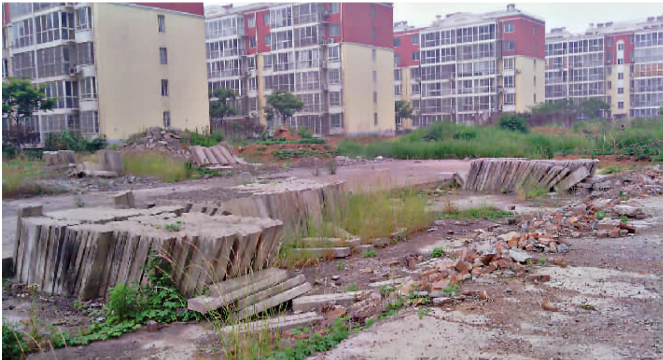
▲新城花园小区西半部的闲置土地上,开发商当初准备建房时拉来的建筑材料堆积至今,无人清理。
