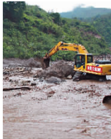
6 月 28 日,抢险人员在四川凉山州宁南县用机械抢通被冲毁的道路。 新华社发
