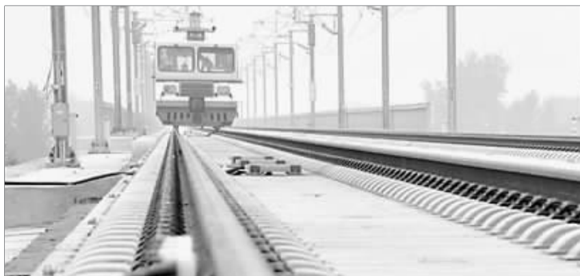
昨日上午,在石武客专鹤壁段,工作人员驾驶轨道车收集遗留的材料。晨报记者 张志嵩 摄
