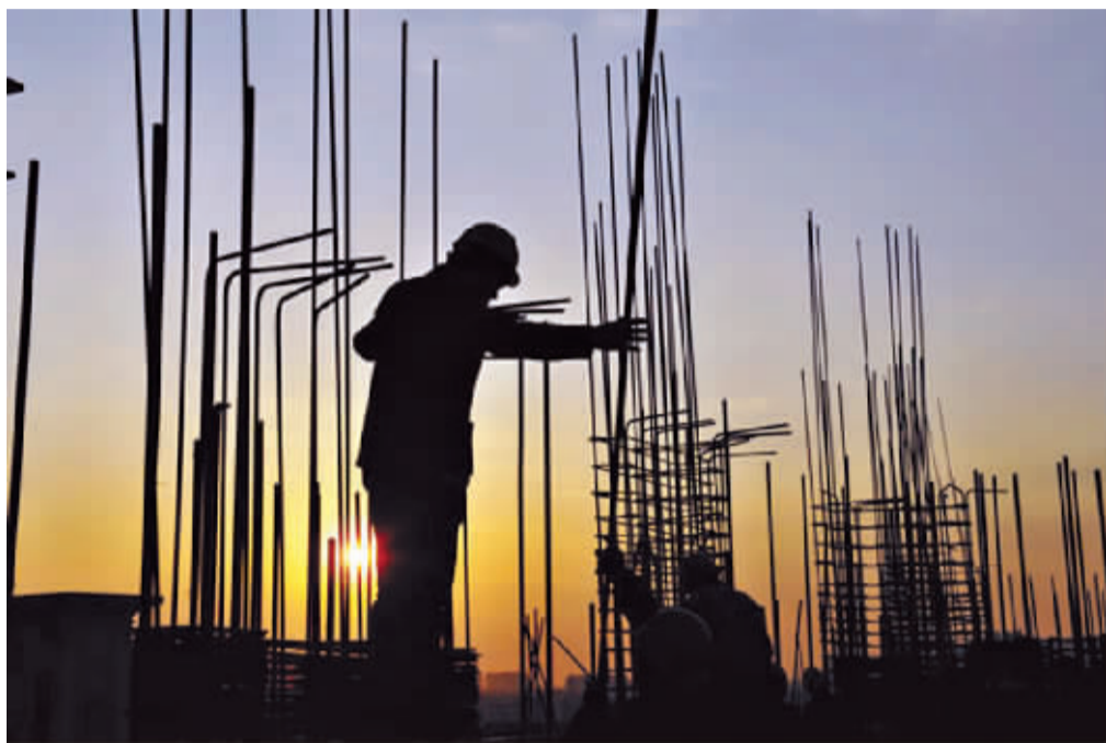
▲ 房地产业形势转暖,开发商重拾信心。图为新区一建筑工地,工人们正在加紧施工。晨报记者 王磊 摄
