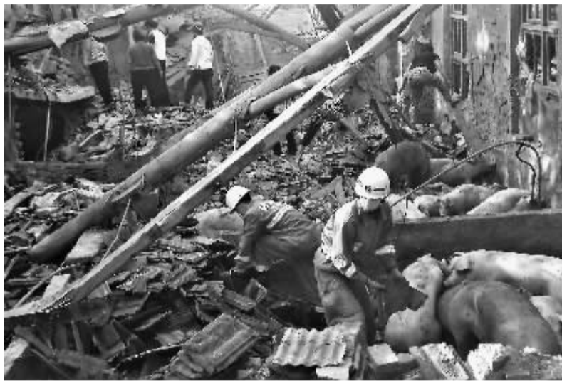
消防战士在倒塌的猪舍废墟上搜救。
