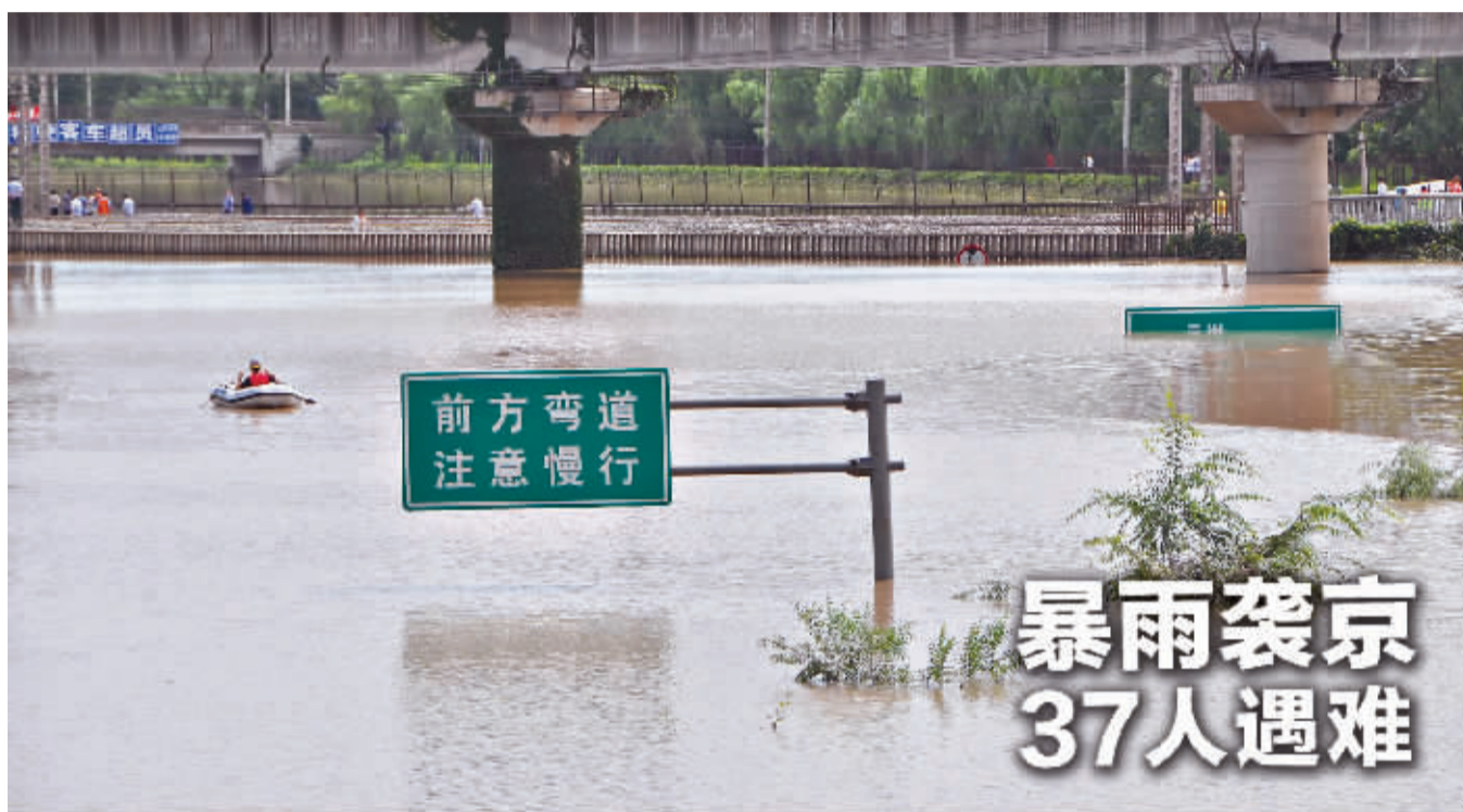
7月22日,京港澳高速北京丰台区南岗洼段被积水淹没。7月21日至22日,北京遭遇61年来最强降雨,致37人遇难。新华社发
