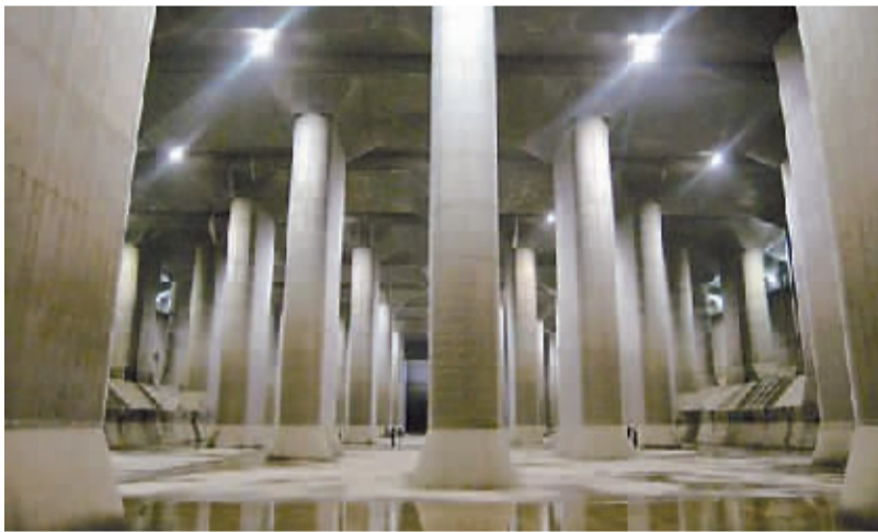
日本东京深达60米的下水道。
