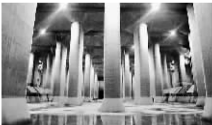
东京地下排水系统被称为“地下神殿”,由一连串混凝土立坑构成,地下河深60米。
