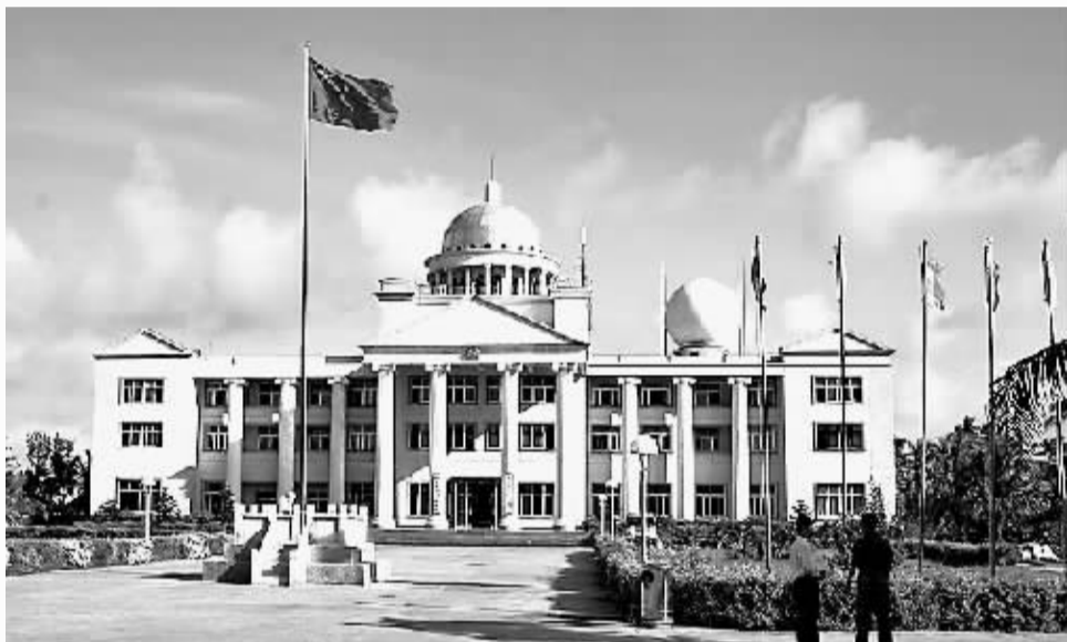
位于三沙市永兴岛的三沙市政府大楼。
