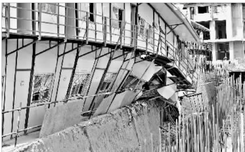
工棚被水泥罐车砸塌。(大河网供图)
