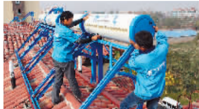
▲恒德公司工作人员在淇县朝歌首府小区安装新飞太阳能热水器。
