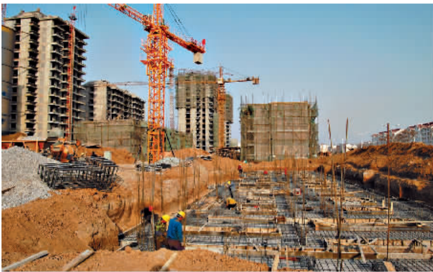
▲ 市洪滨一安置小区的施工现场。
