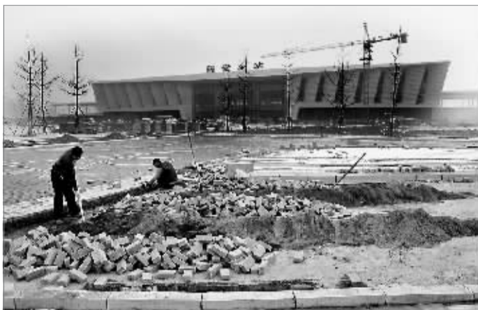
11月22日,鹤壁东站站前广场已经初具规模,正在进行铺砖、绿化。
