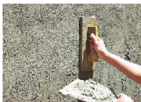
墙面刮腻子需要有足够的温度，才能保证施工的规范。
