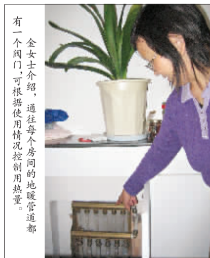
王女士介绍,通往每个房间的地暖管道都有一个阀门,可根据使用情况控制用热量。
