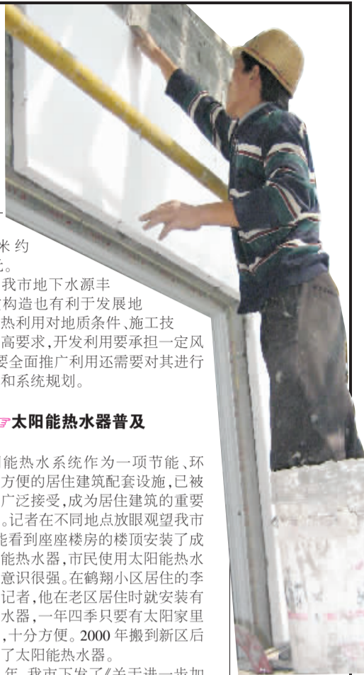
建筑工人正在给墙体粘贴外墙保温材料——聚苯乙烯板。
