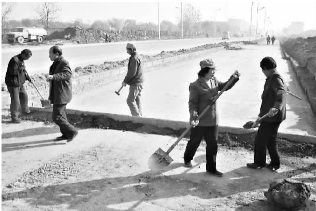
11月21日,施工人员正在修建位于黄河路西段的快速通道慢车道。慢车道全长980米,投资200余万元,完工后将使快速通道的行车更加通畅。工程预计12月中旬竣工。 记者 王娜 摄
